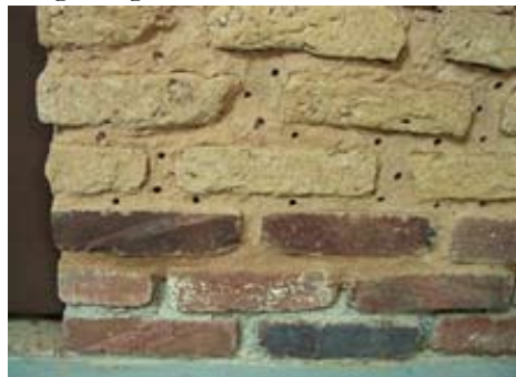
Lehmziegeln auf tragfähigem Fundament.
